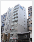
エリッツ四条河原町ビル 京都市下京区
