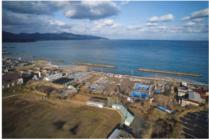
増設工事中の循環型中間養殖場（青森県今別町）
