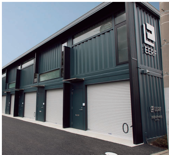
新小岩EERF（2階オフィス、1階車庫）
