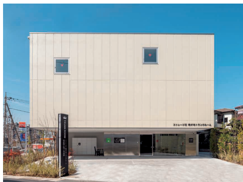
梶が谷トランクルーム（神奈川県）外観
